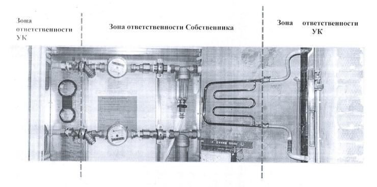
раницами ответственности по канализации является место присоединения отводящей трубы канализации фтиры к тройнику или кресту транзитного стояка домового водоотведения. Отводящую трубу и всю нализационную разводку внутри квартиры обслуживает Собственник. Тройник или крест транзитного тояка и сам стояк обслуживается Управляющей компанией.
